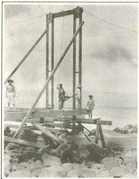
Trabajos del rompeolas
