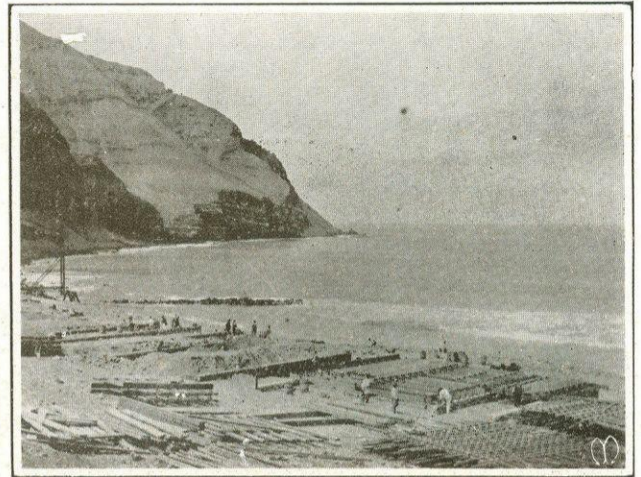
Establecimiento de baños en construcción Fotos López
